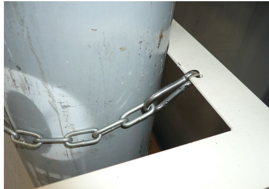
対策後のフック
