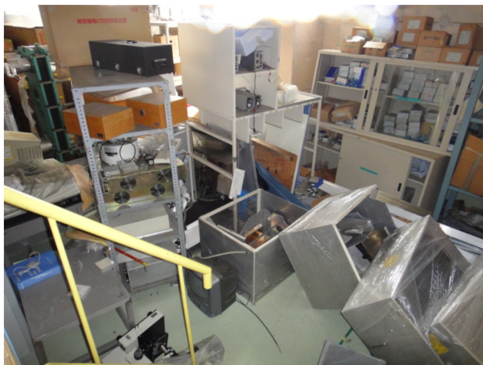
↑ 固定していた棚が倒れ、ストック品が破損
