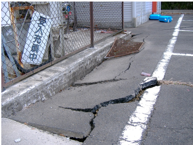
↑ ↓ 陥没したMNC外周のアスファルト
