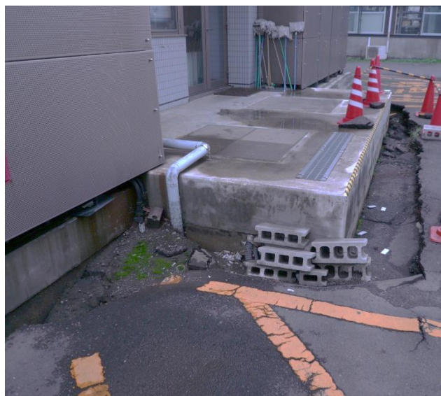
↑ 陥没した建物外周のアスファルト (2011.6.28)
