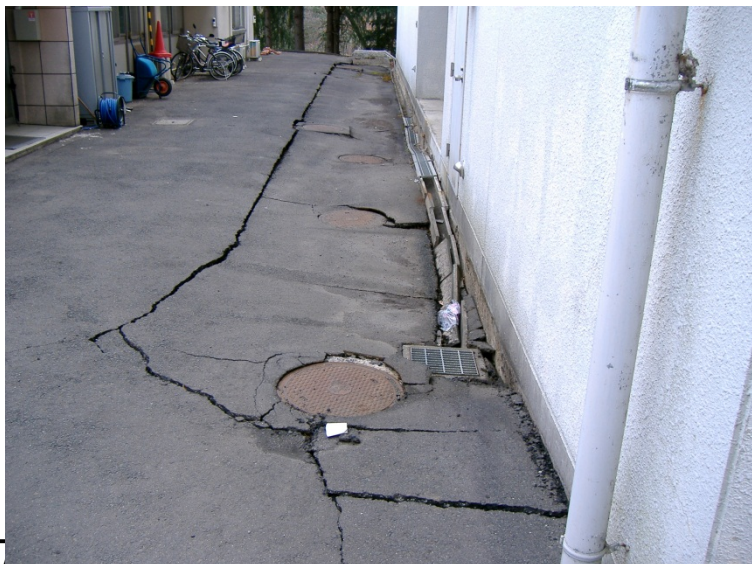
↑ ↓ 陥没したMNC外周のアスファルト
